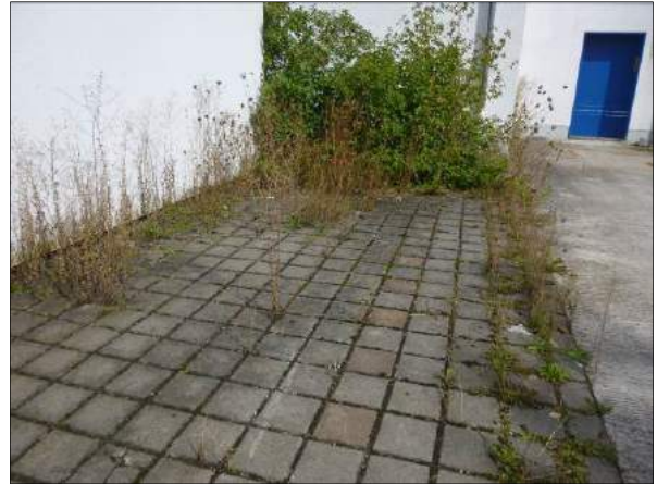
Abb. 7: Fugenvegetation im südlichen Parkplatzbereich
