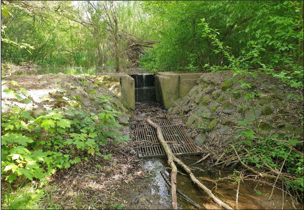
Abb. 12: Auslassbauwerk am Rückhaltebecken im Norden des Plangebietes
