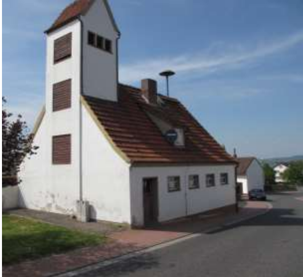
rechte Gebäudehälfte Vorderansicht
