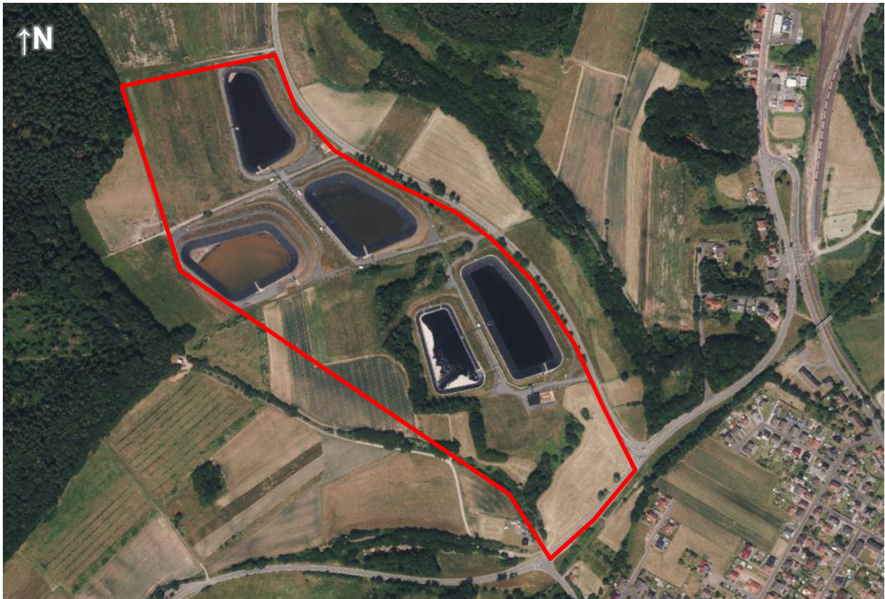
Abbildung 7: Luftbild des im Regionalplan Nordhessen 2009 für Heringen (Werra) ausgewiesenen ‚Vorranggebiet Industrie und Gewerbe Planung‘ (rot umrandet) mit darauf zu erkennenden Stapelbecken der K+S und nahegelegener Wohnbebauung (veränderte Darstellung nach: Hessische Verwaltung für Bodenmanagement und Geoinformation, Digitale Orthophotos 2024).
