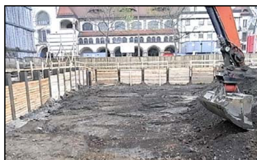
Abb. 4. Schichtenweiser Abtrag, verpflichtend bei baubegleitender KMR
